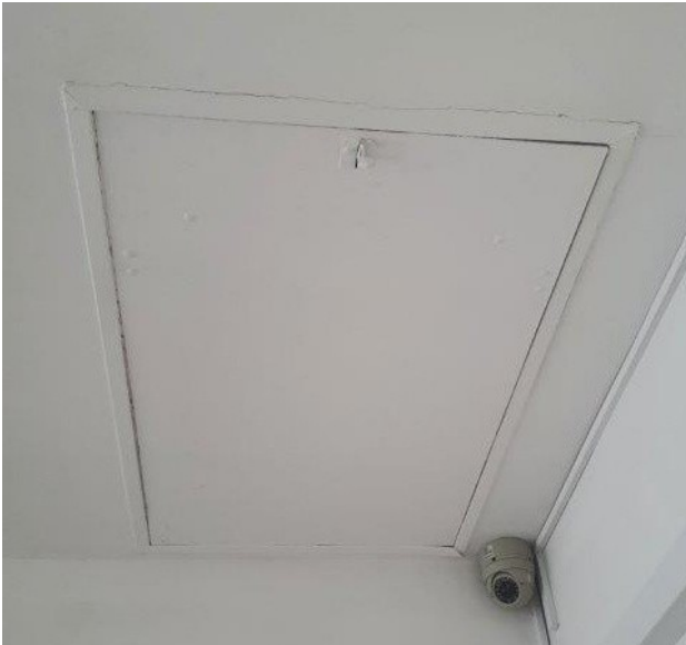
Widok klapy z klatki schodowej na poddasze
