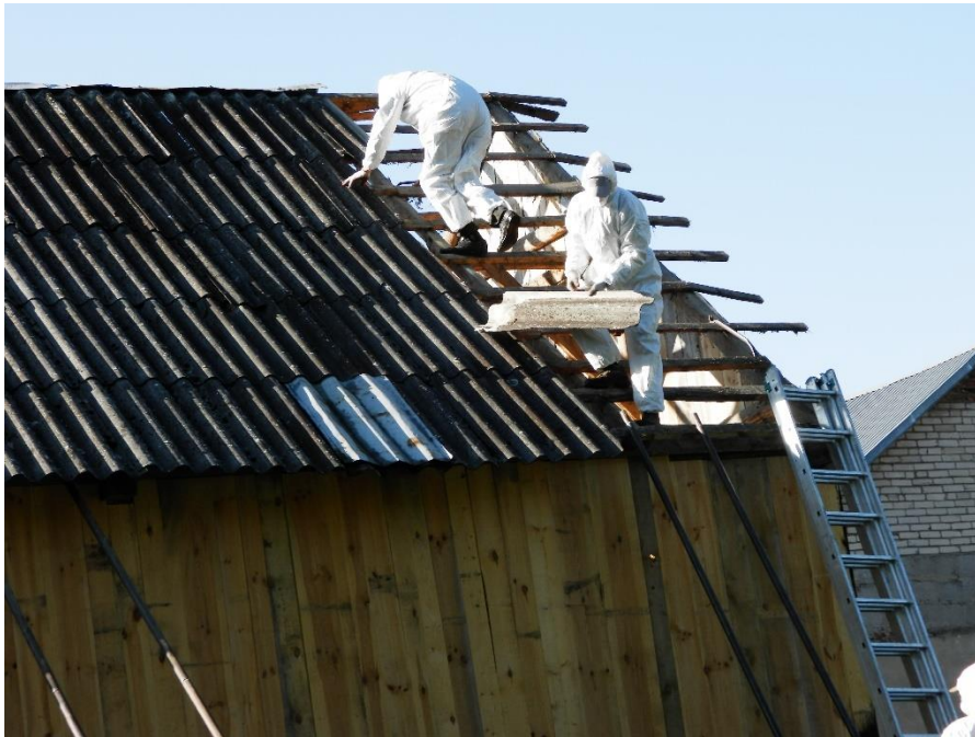
Unieszkodliwienie (demontaż) wyrobów zawierających azbest
