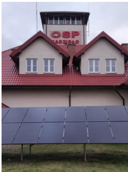
Zakup i montaż instalacji fotowoltaicznej w Ochotniczej Straży Pożarnej w Kadzidło
