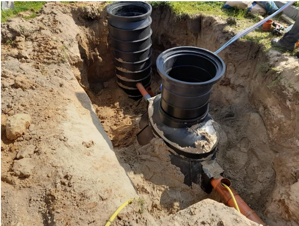
Budowa przydomowych oczyszczalni ścieków na terenie gminy Stara Biała
