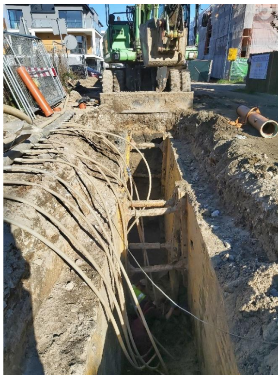
Budowa sieci kanalizacyjnej w drodze dojazdowej do ul. Jeziorowej 45A/47A wraz z odcinkami sieci od kanału głównego do granic nieruchomości w Warszawie na terenie dzielnicy Wawer
