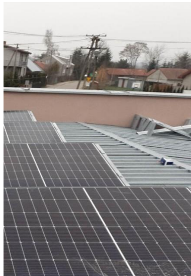
Zakup i montaż instalacji fotowoltaicznej na budynku strażnicy OSP w Szulmierzu
