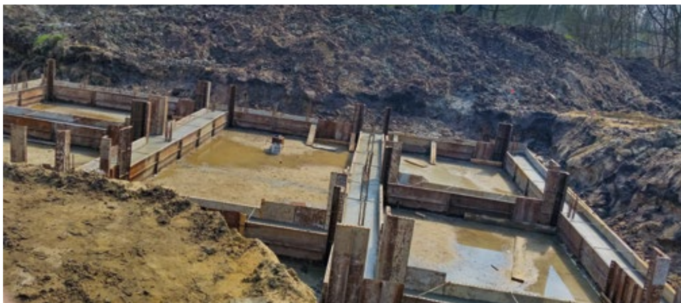
Budowa oczyszczalni ścieków w miejscowości Ruda Talubska, gm. Garwolin
