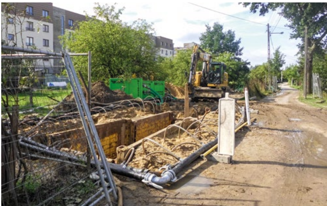
Budowa sieci kanalizacyjnej w ulicy Życzliwej w Warszawie w Dzielnicy Białoleka
