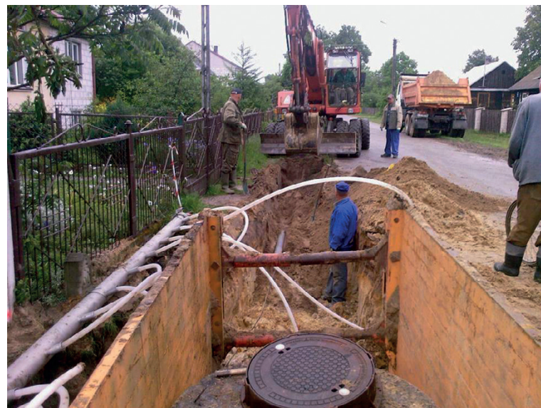
Budowa wodociągu w Gołębku- lipiec 2010
